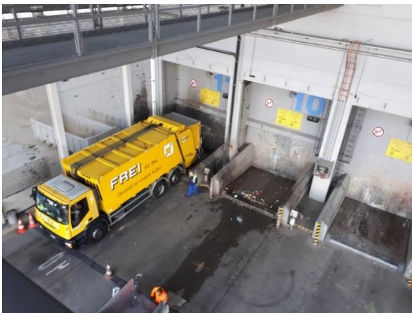
Figura 03: Área de descarregamento dos resíduos no fosso via modal rodoviário em Zurique. Fonte: Visita técnica do autor no incinerador Zurique na Suíça (2017).
