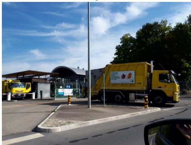
Figura 12: Foto da portaria de entrada dos caminhões no incinerador SIG (Suíça). Fonte: Visita técnica do autor no incinerador de Zurique na Suíça (2017).
