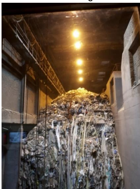
Figura 06: Área de armazenagem de resíduos (fosso).
