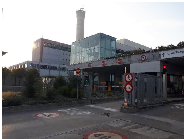
Figura 09: Foto da portaria do incinerador Hagenholz em Zurique (Suíça). Fonte: Visita técnica do autor no incinerador de Zurique na Suíça (2017).
