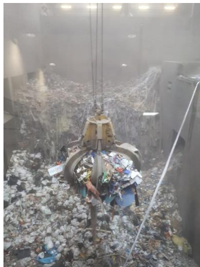
Figura 07: Guindaste rolante em operação no fosso de armazenagem dos resíduos. Fonte: Visita técnica do autor no incinerador da TRIDEL Lausanne na Suíça (2017).
