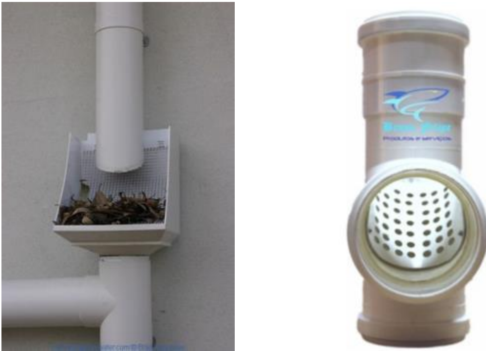
Figura 15 – Exemplos de filtros para sólidos grosseiros (Folhas).
