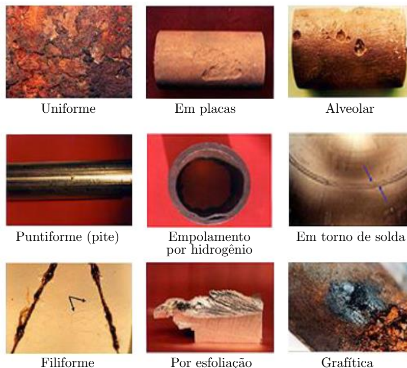
Figura 1: Algumas formas de corrosão Fonte: adaptado de GENTIL, 2003.
