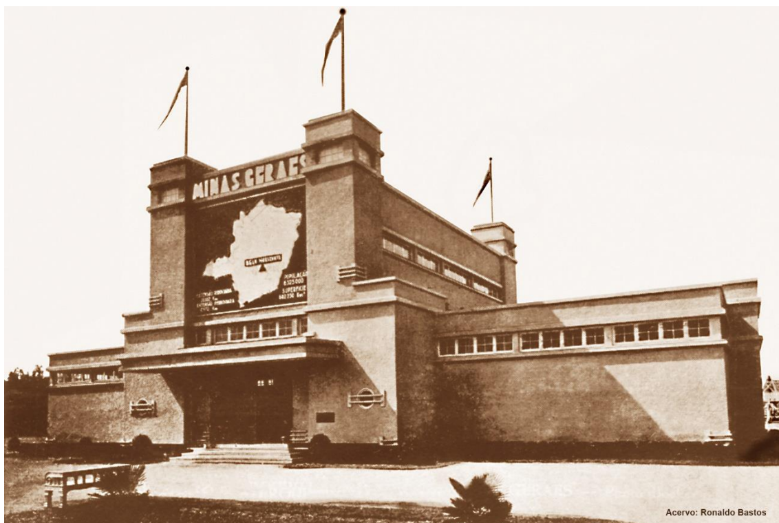
Fotografia 27 - Pavilhão do estado de Minas Gerais
