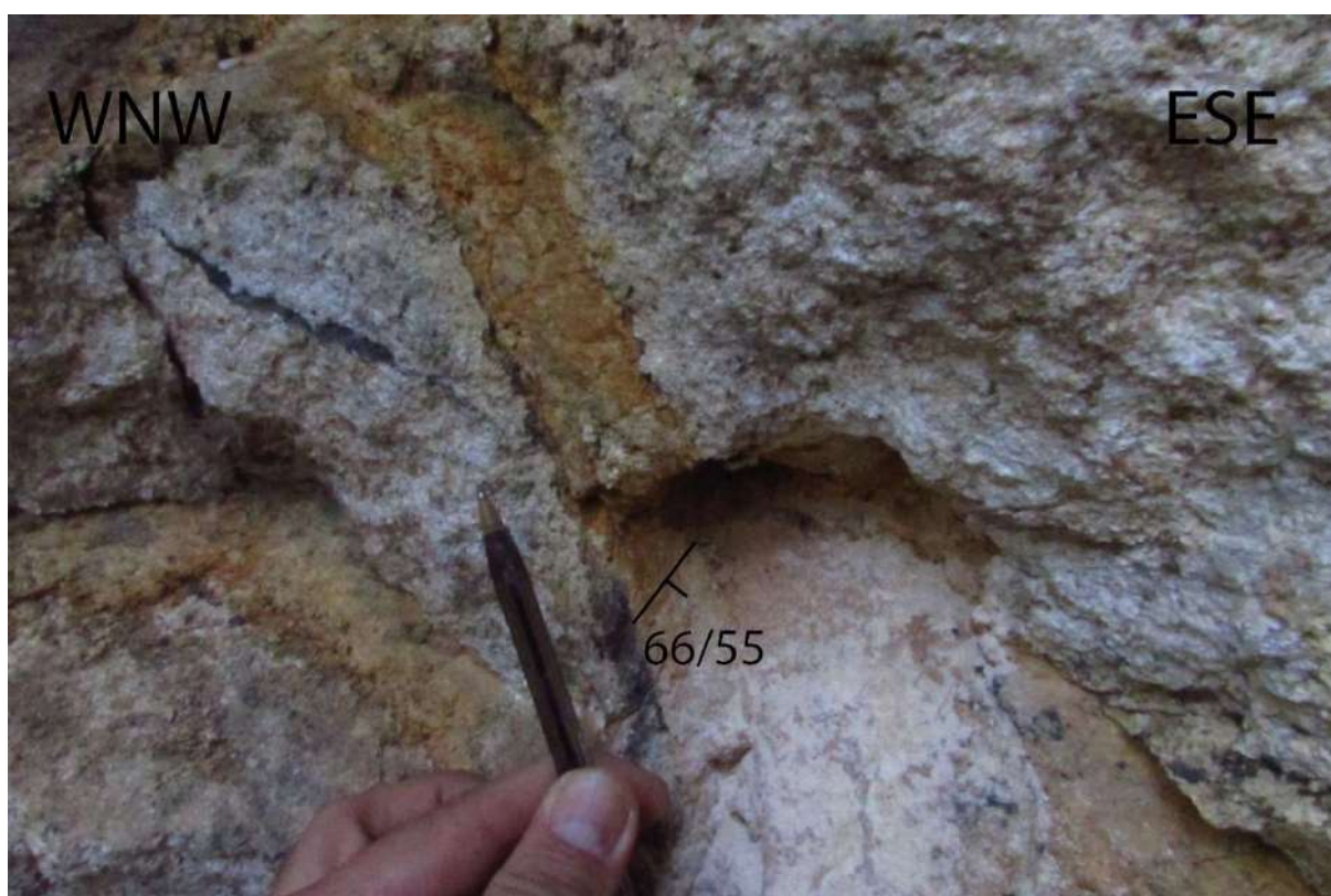
Figura 69 – Fratura NW-SE preenchida por argila.,
