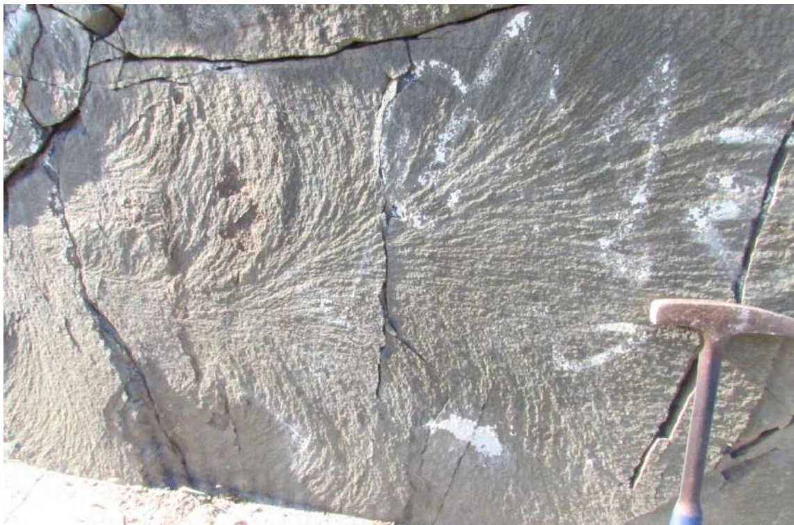
Figura 49 – Fratura em dique de diabásio apresentado pluma de extensão
