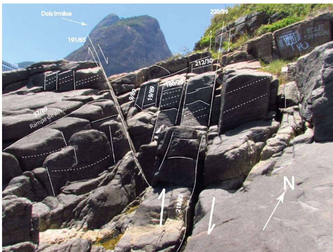
Figura 100 – Corredor de fraturas de direção NW-SE
