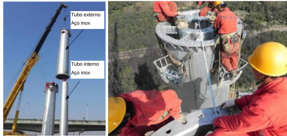
Figura 5 – Utilização de colunas CFDST em poste de alta tensão [11]
