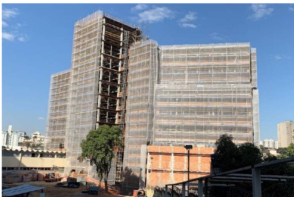
Figura 33 - Fotografia do estágio da obra no momento dos ensaios desta tese.
