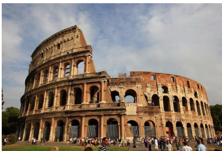
Figura 1 - Coliseu, início da construção na década de 70, século I [2].
