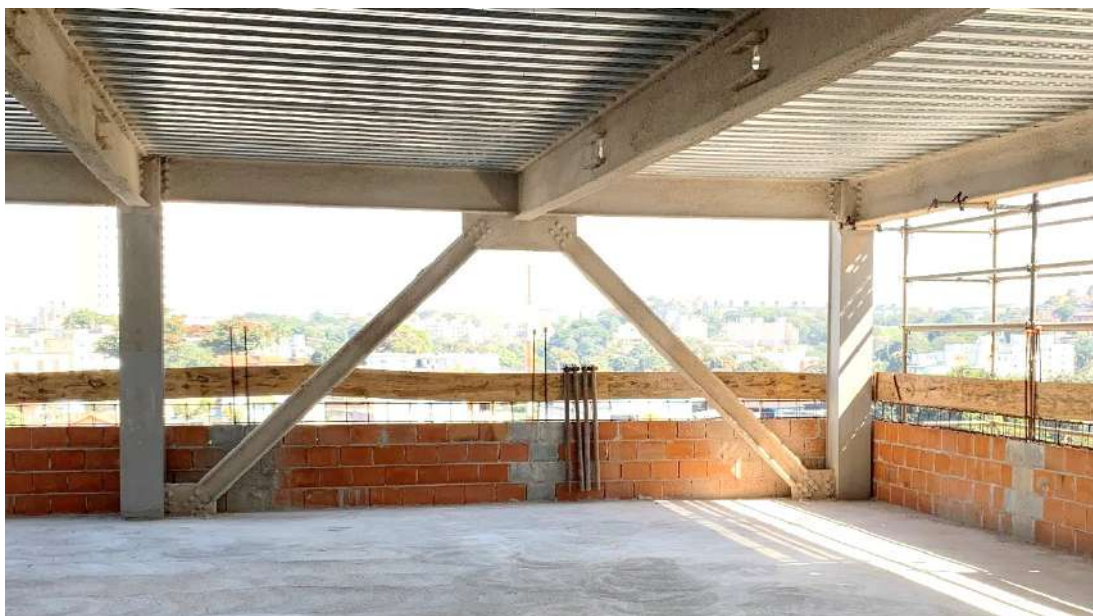
Figura 39 - Detalhe do contraventamento no 8º pavimento da edificação.
