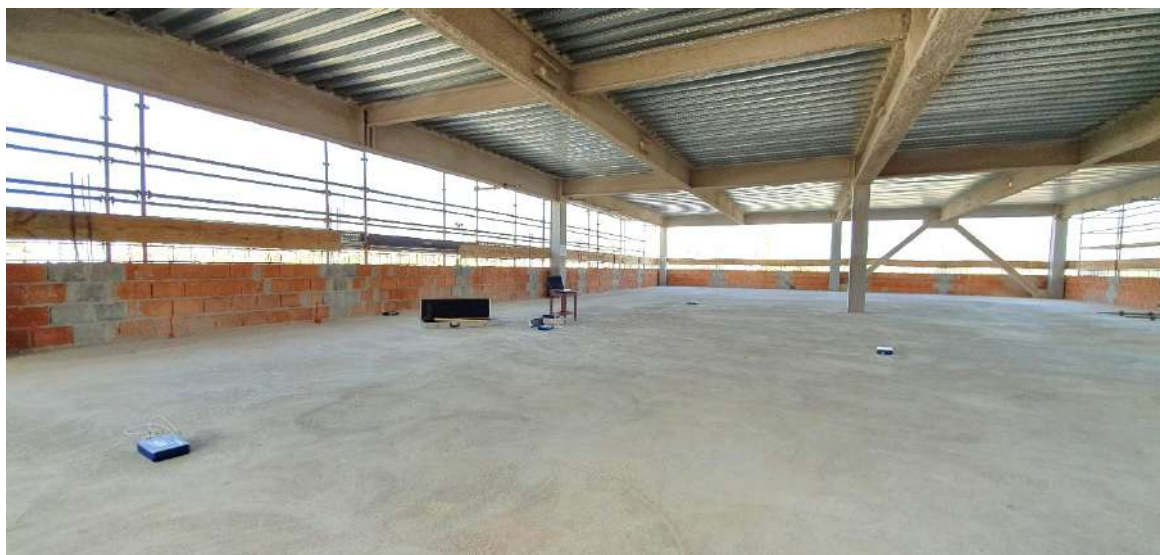
Figura 38 - Fotografia do 8º pavimento da edificação investigada.
