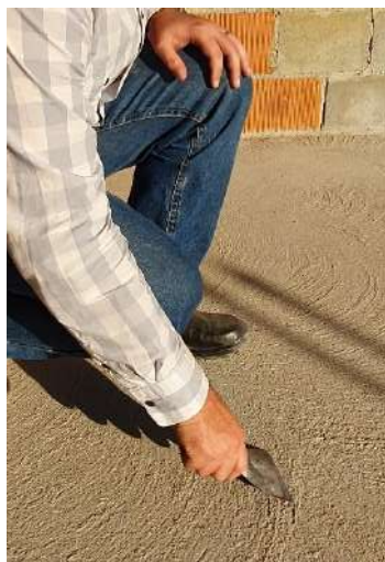
a) Regularização da base
