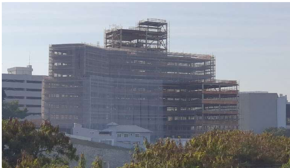
Figura 32 - Fotografia do estágio da obra no momento dos ensaios desta tese.
