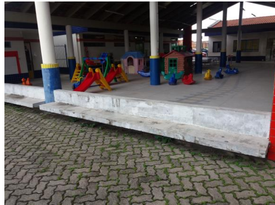
Figura. 26- Cobertura do pátio
