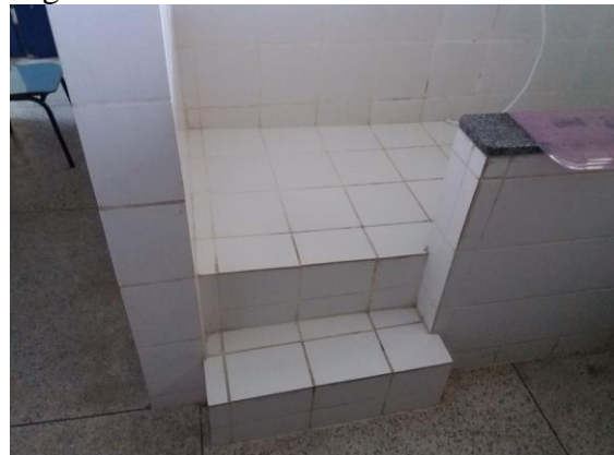
Figura 54- Banheiro de sala
