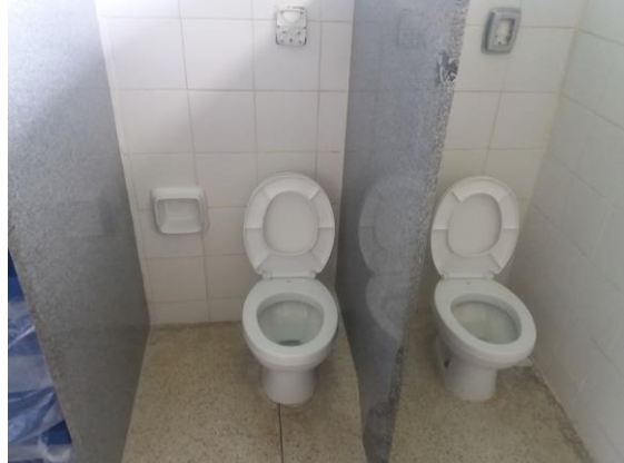
Figura 52- Banheiro de sala
