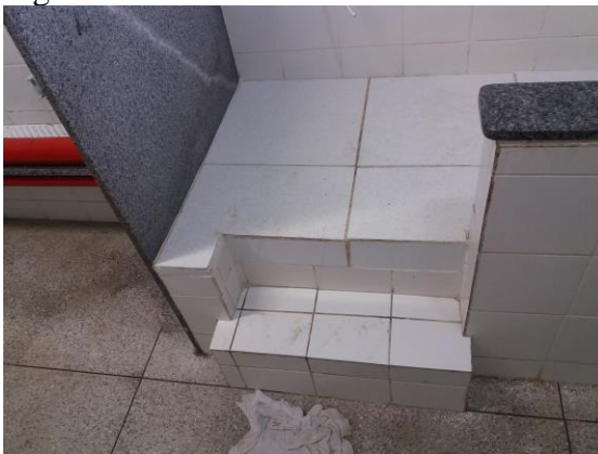
Figura 39- Cabines dos sanitários
