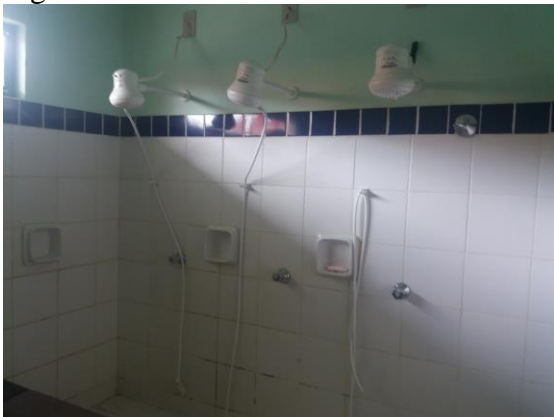
Figura 53- Banheiro de sala
