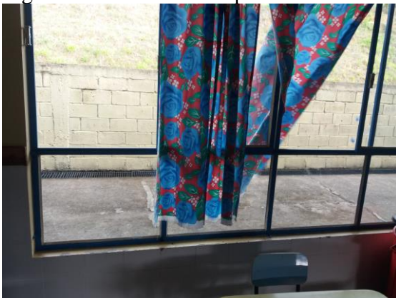
Figura 43- Janelas vistas pelo interior da sala
