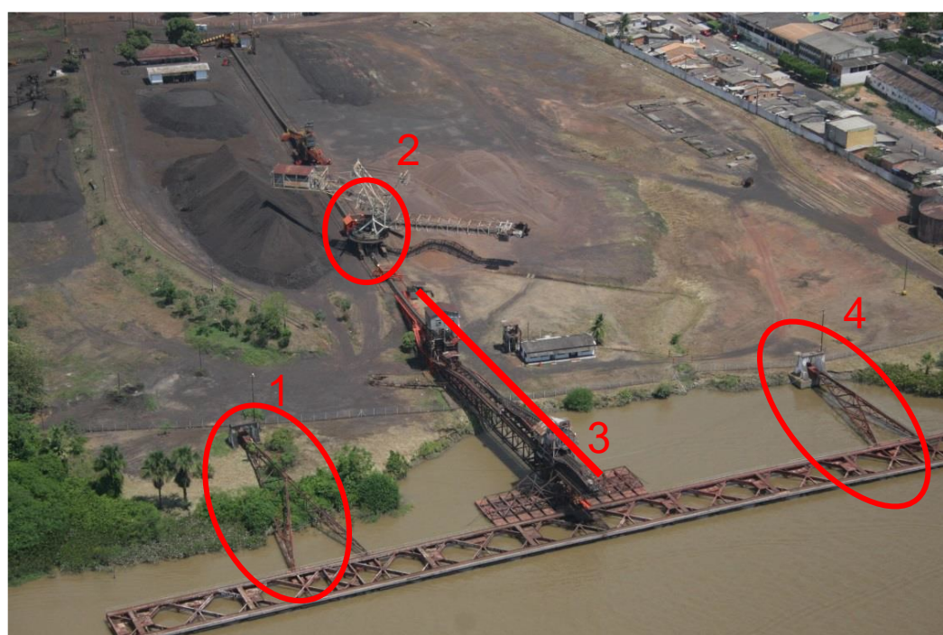
Figura 13 – Cenário da margem do Rio entre 1993 e o sinistro de 2013, com 1) rótula oeste, 2) retomadora de caçambas, 3) correia transportadora e 4) rótula leste (Pacheco et al. , 2014)
