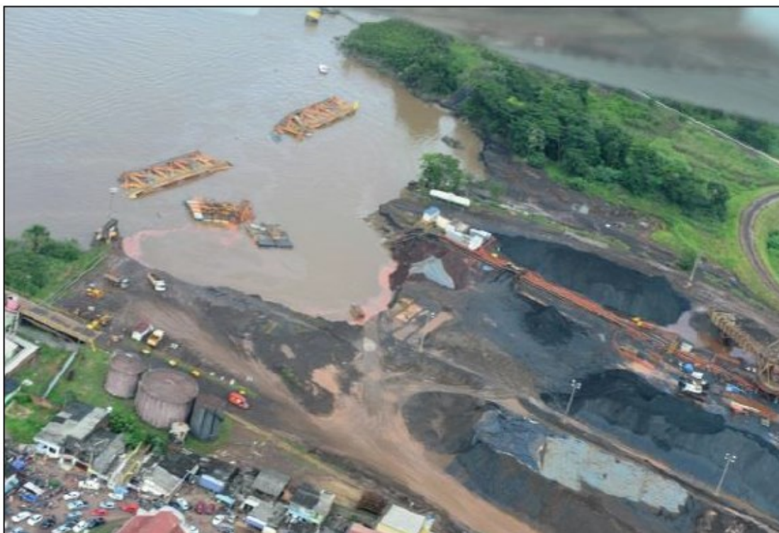
Figura 22 – Foto aérea do sinistro de 2013, com destaque para as caixas de decantação e a pilha de minério que teve parte do material escoado para o rio (UON, 2014)
