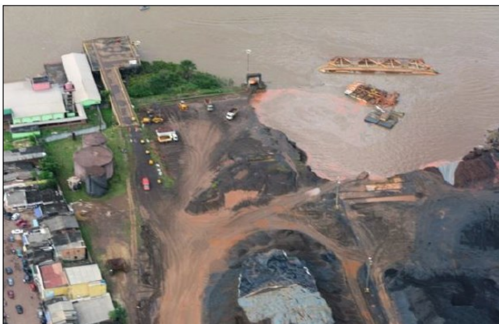
Figura 23 – Cenário pós ruptura do trecho leste (UON, 2014)
