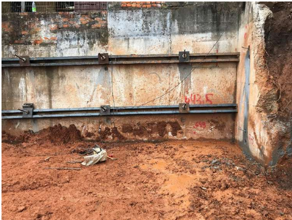
Figura 53: Vigas atirantadas.
