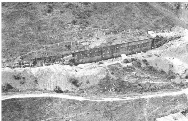
Figura 37: Detalhes da obra experimental em solo grampeado (Feijó e Ehrlich, 2005 e 2006).
