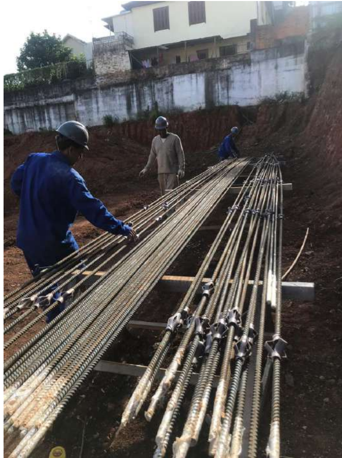
Figura 52: Montagem dos grampos e colocação dos centralizadores.
