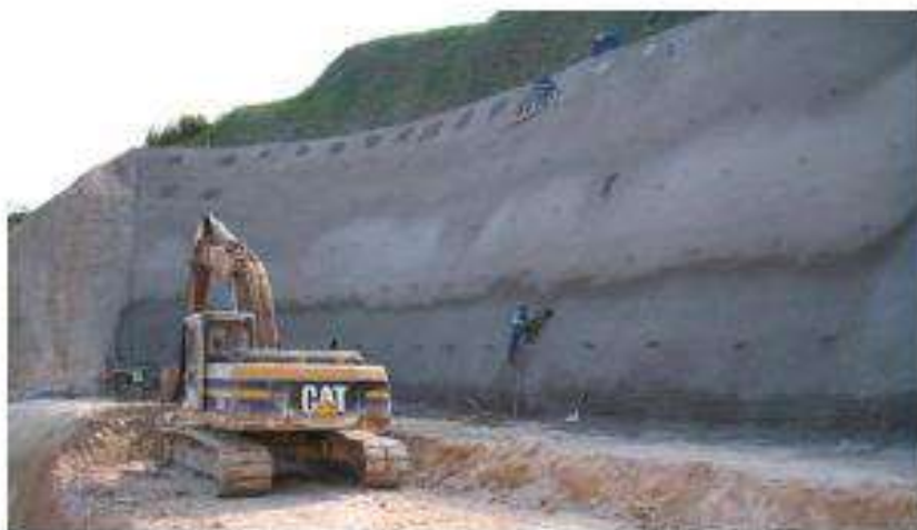
Figura 7: Fase de escavação (LIMA, 2007).
