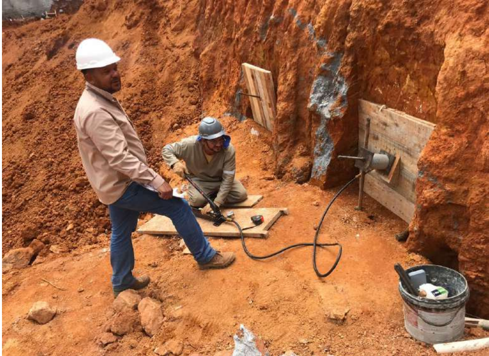
Figura 61: Execução do ensaio de Arrancamento.
