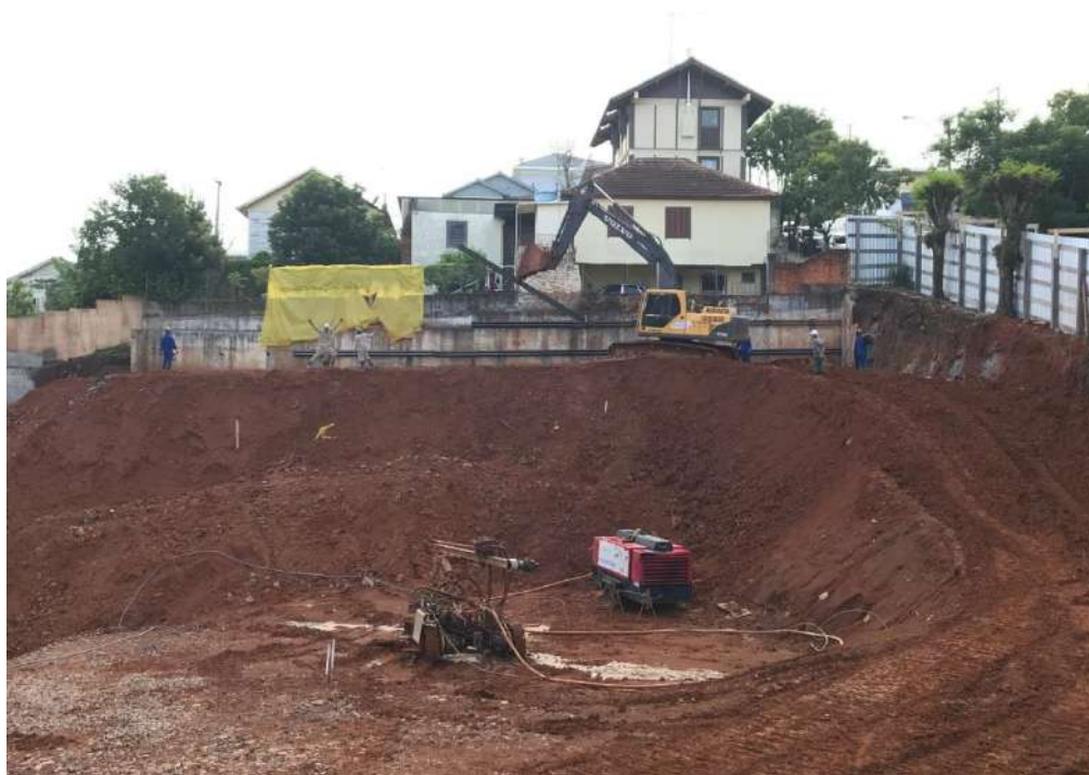
Figura 54: Vigas atirantadas no muro preexistente.
