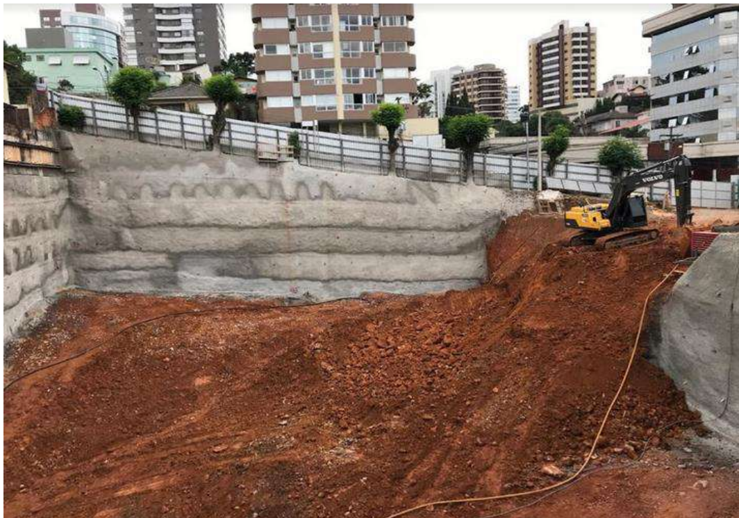
Figura 45: Foto da obra sendo executada.
