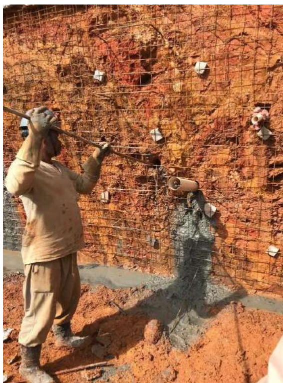
Figura 75: Instalação do TT-02.
