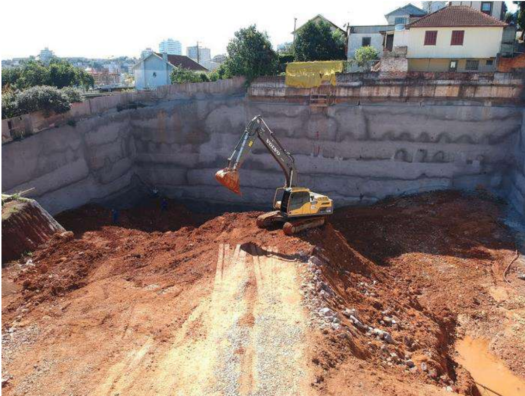
Figura 44: Foto da obra sendo executada.
