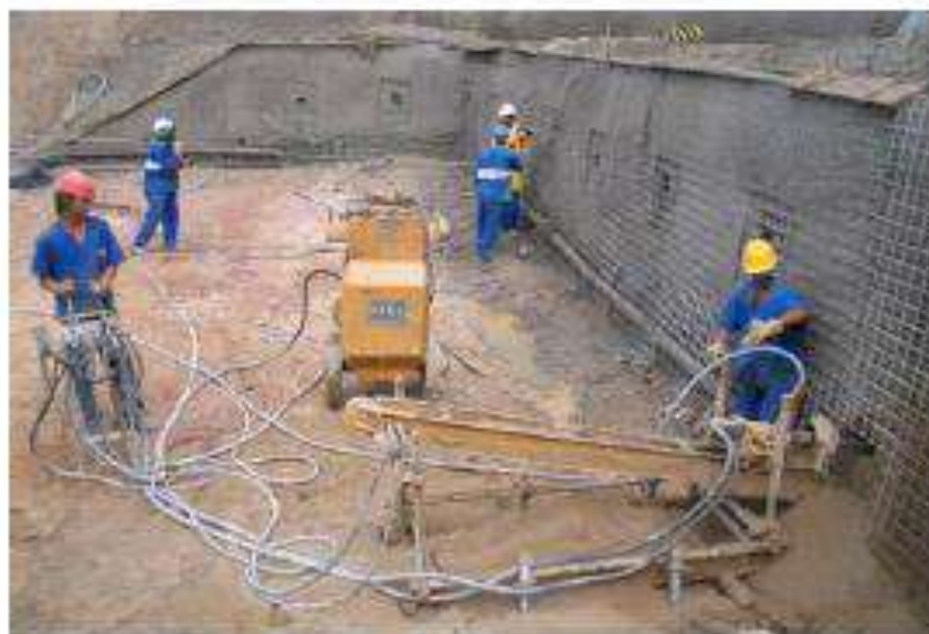
Figura 9: Execução do furo para a inclusão de grampo (LIMA, 2007).
