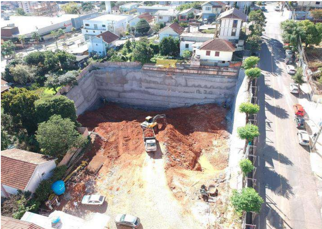
Figura 43: Foto aérea da obra.
