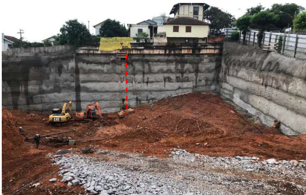
Figura 74: Foto da obra – 13/05/19.
