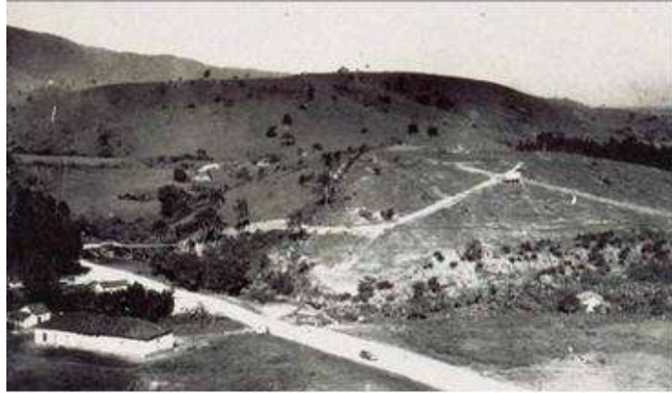
Figura 11 – Morro das Pitas, pedra fundamental e terraplanagem
