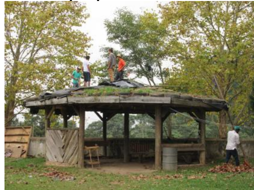
Figura 19: Educandos reformando estrutura construída pela primeira turma da ELAA.
