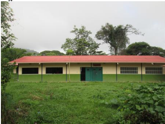
Figura 26: Prédio de aulas.
