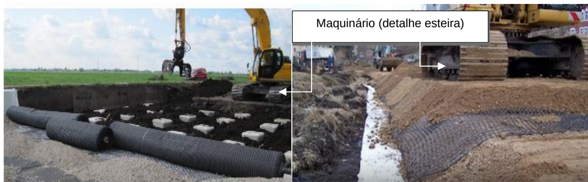
Figura 49: Circulação de equipamentos para construção do aterro
