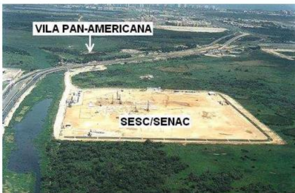
Figura 37: Fase inicial da construção do SESC/SENAC com indicação do local das futuras obras da Vila Pan-Americana (adaptado de Spotti, 2006)
