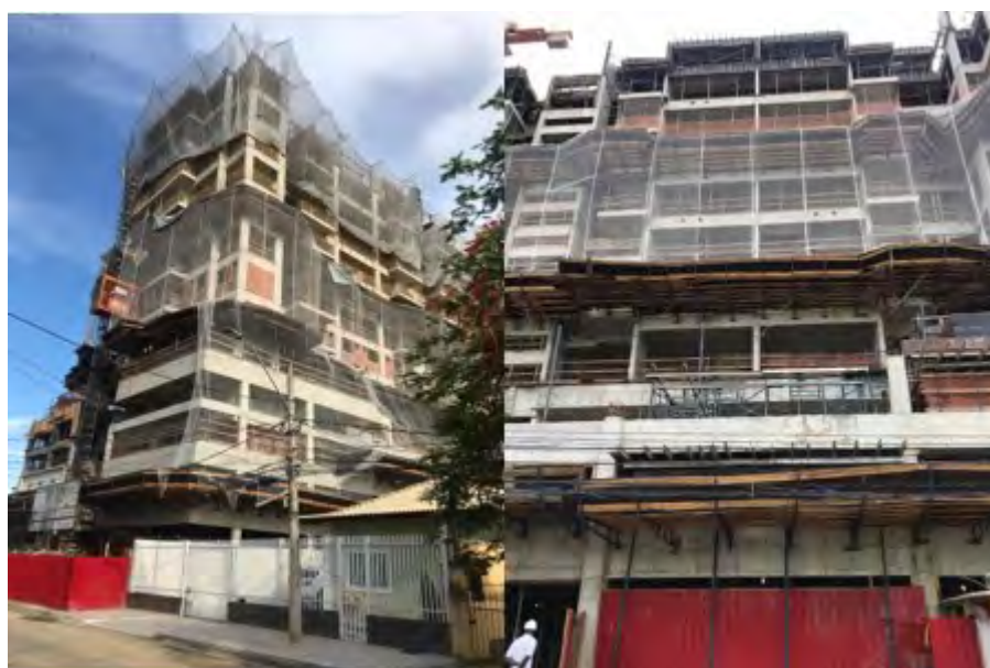
Figura 2.12 – Execução da Edificação (Sigma1 Consultoria & Projetos).
