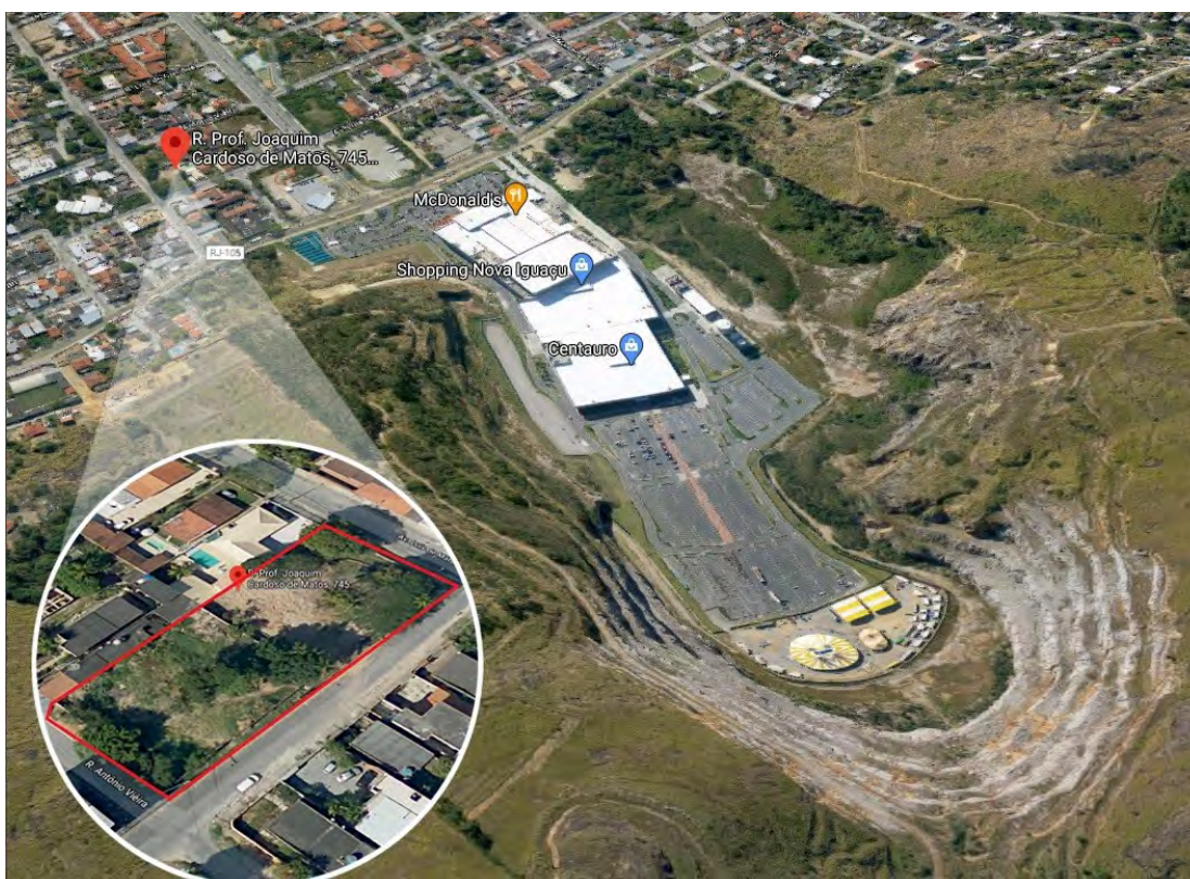
Figura 2.1 – Localização da construção.
