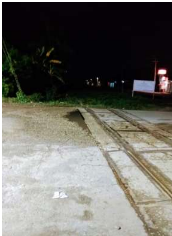
Figura 93 - Linha férrea sobre a ponte
