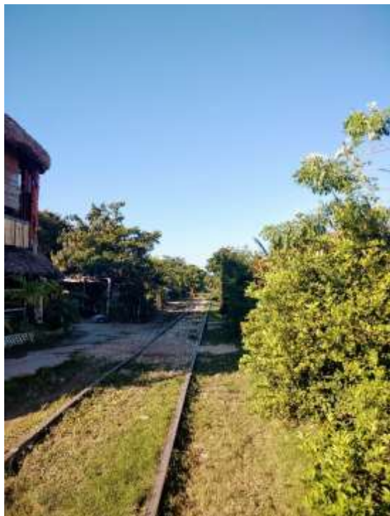
Figura 91 - Linha férrea ao lado da ponte
