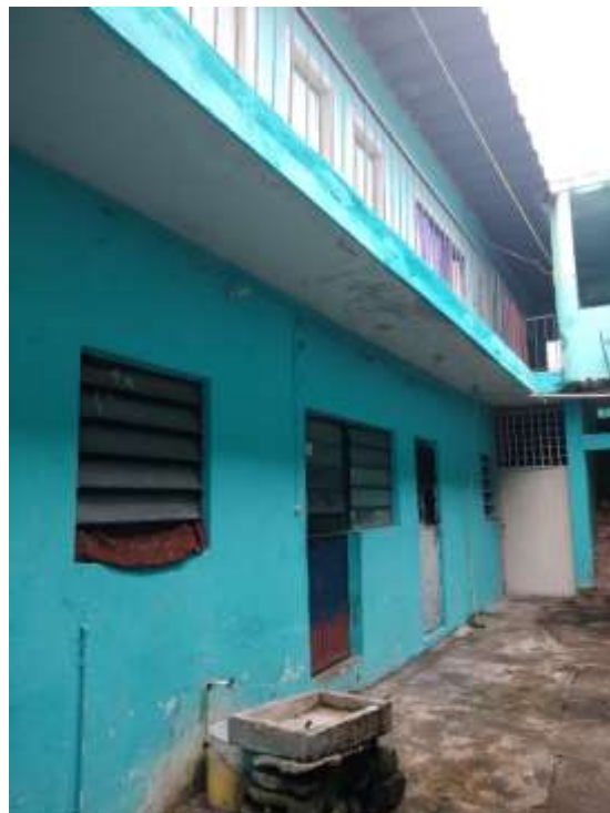
Figura 111 - Pátio interno da estalagem
