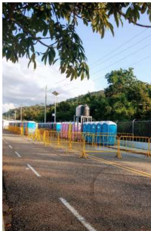
Figura 81 - Banheiros químicos instalados pela COMAR
