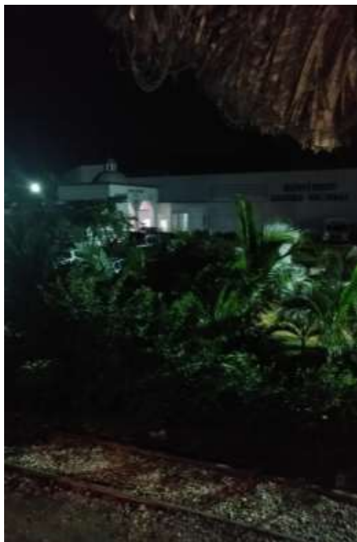
Figura 94 - Prédio da Guarda Nacional ao lado da linha férrea
