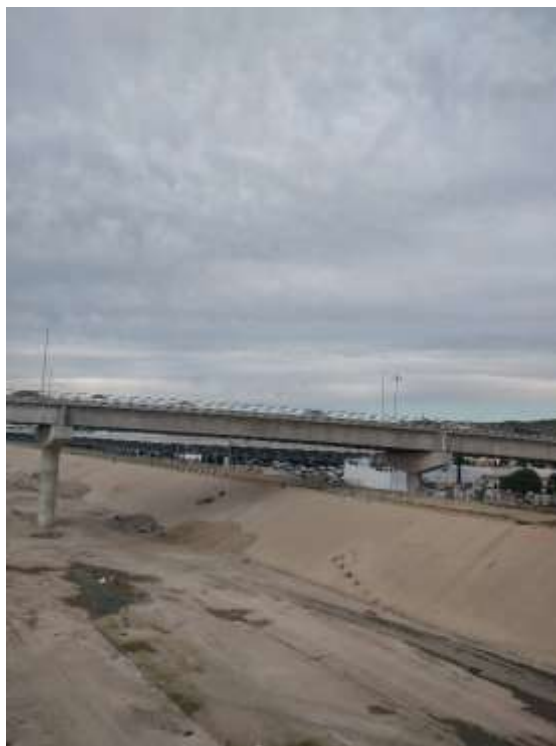
Figura 17 - Rio Tijuana e Viaduto
