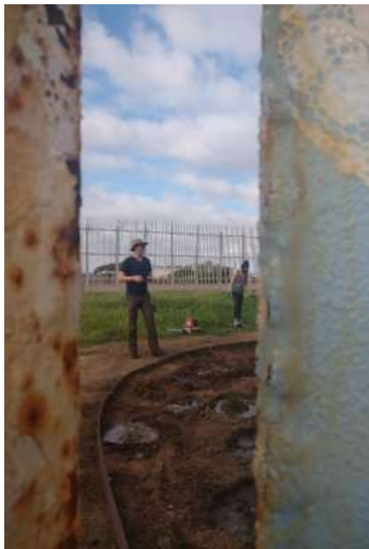
Figura 53 - Construção do jardim entre muros
