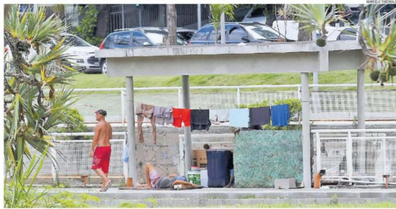
Descaso. Moradores de rua ocupam um trecho do Jardim de Alah e estendem roupas em varal improvisado: área de lazer tem vigas de concreto e vergalhões abandonados
