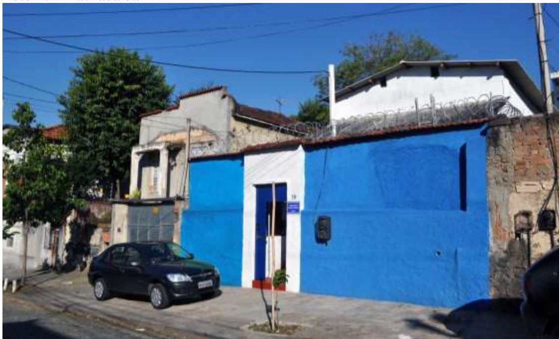
Foto 27 – Fachada da TETT
