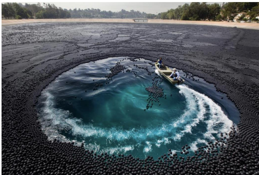
Figura 35 - Bolas de sombra em reservatório de Los Angeles. Fonte: Goniadis (2015)
