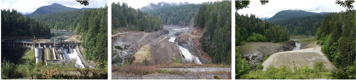
Figura 12 - Descaracterização da barragem Elwha. Fonte: NPS (2020)
