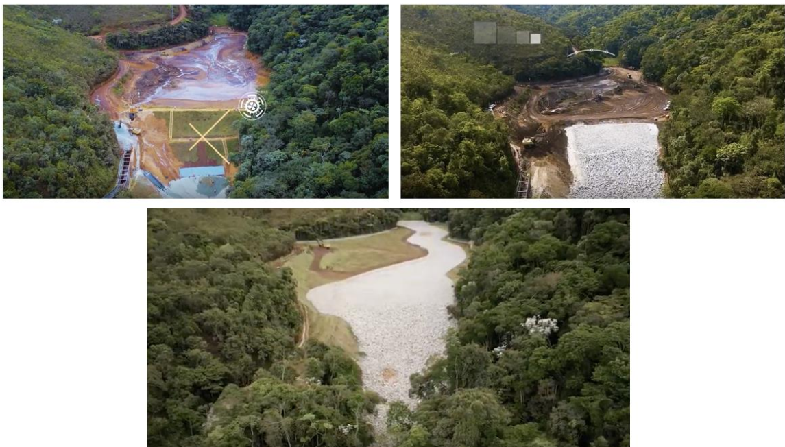
Figura 13 - Descaracterização da barragem B8. Fonte: Vale (2020)
