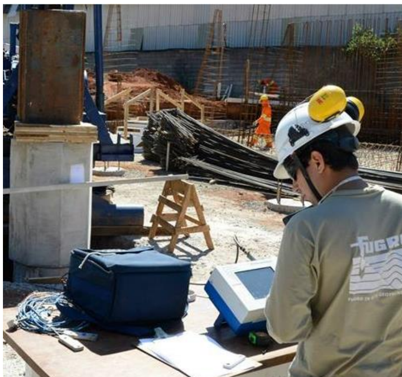
Figura 8 – Execução do ensaio de carregamento dinâmico (Autor).
