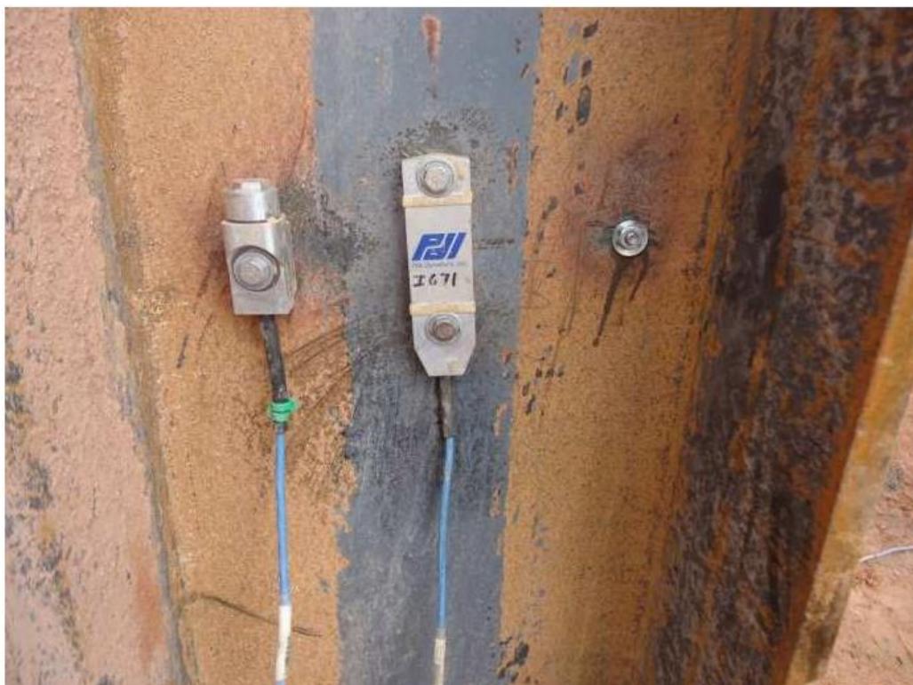
Figura 33 - Acelerômetros e transdutores de deformação instalados em uma estaca da obra.
