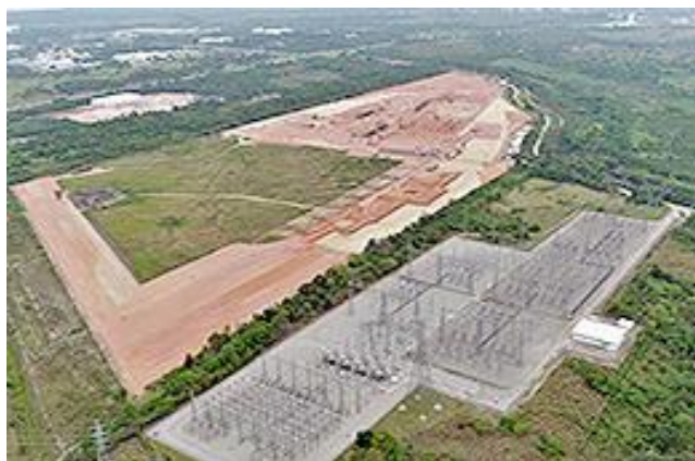
Figura 20 – Foto aérea da obra em implantação (Google Maps)
