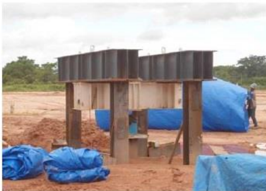
Figura 28 - Vista geral de uma PCE da obra.
