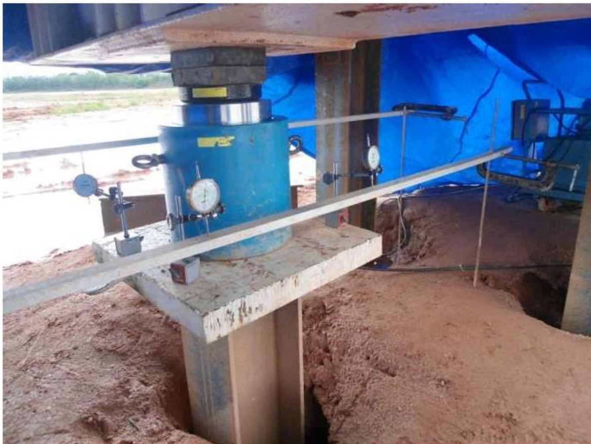
Figura 12 – Prova de carga estática na obra em pesquisa.
