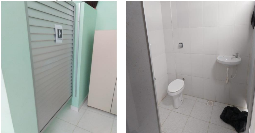
Foto 6 - Banheiro para pessoa com deficiência
