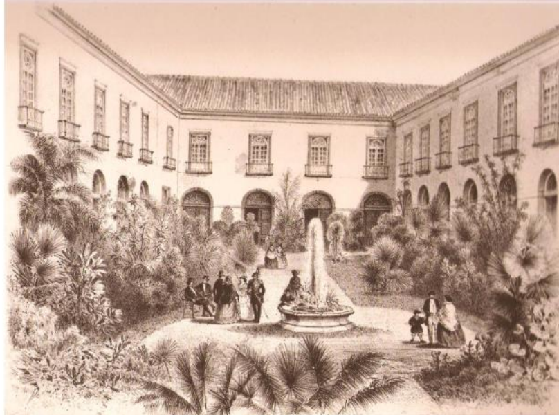
Figura 14 - Jardim Improvisado no pátio central do Palácio da Exposição.
