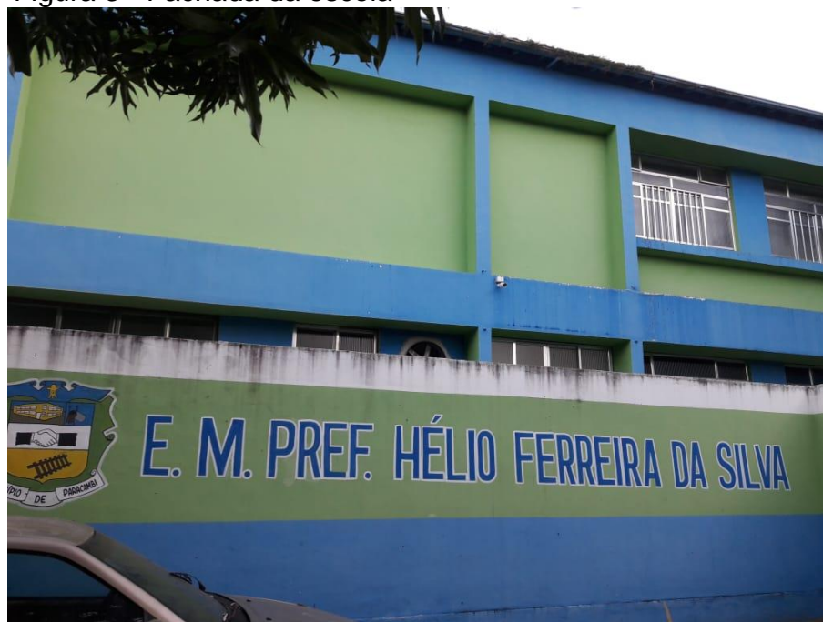
Figura 3 - Fachada da escola
