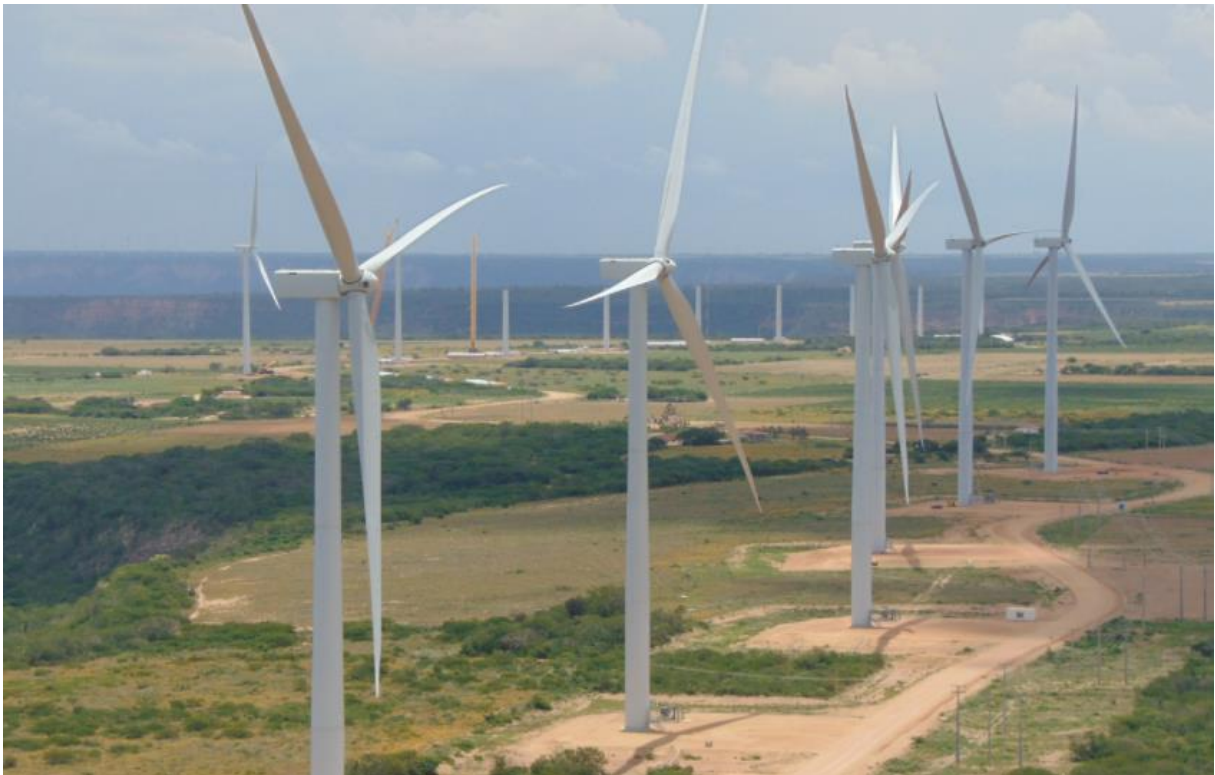
Figura 2 – Parque eólico em Araripe – www.casadosventos.com.br
