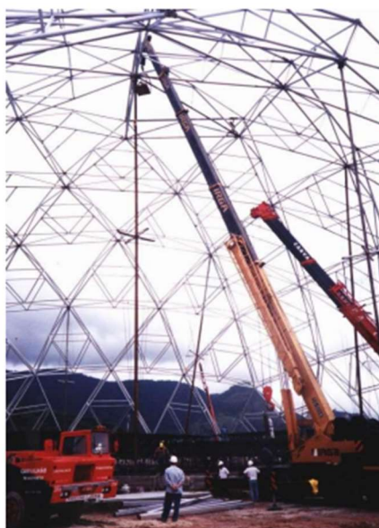
Figura 3 – Sistema de escoramento com colunas estaiadas e protendidas
