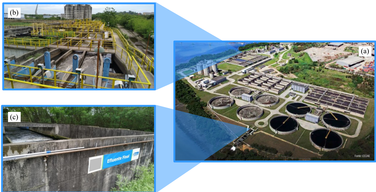
(a) Vista aérea da ETE avaliada; (b) Foto da calha Parshall no início da ETE; (c) Foto do lançamento do efluente final. Fonte: foto (a) – CEDAE (2022); fotos (b) e (c) – O autor (2022).
