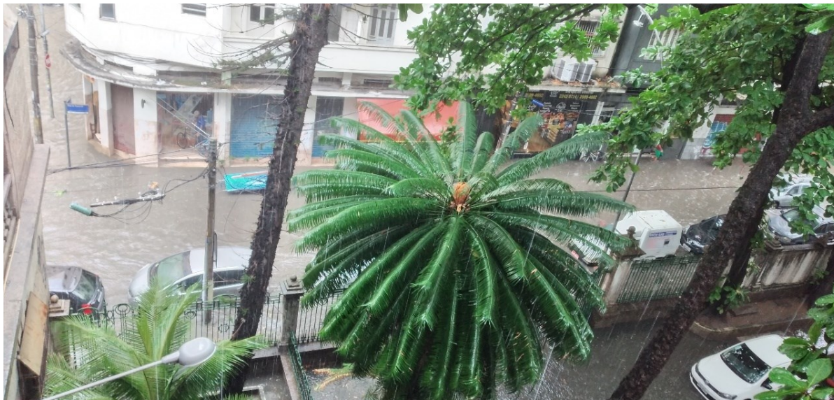
Figura 35 – Foto da vista do pátio interno do prédio anexo (COAGE) do INCA alagado na Rua do Resende durante precipitação intensa no dia 22/02/2021
