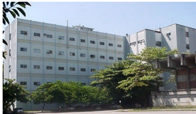
Figura 40 – Vista da fachada dos fundos do PHC
