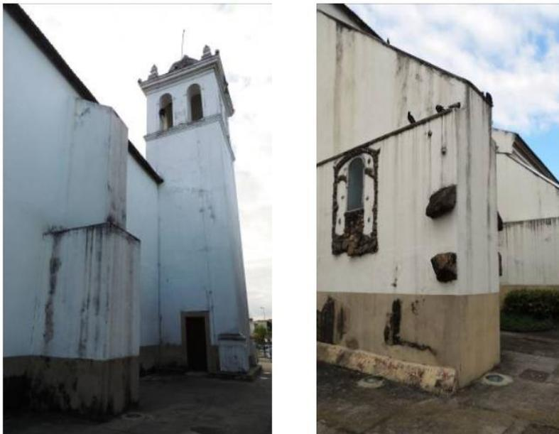
Legenda: Lateral direita e esquerda da matriz. O reforço estrutural classificado como: “gigante - maciço de alvenaria de reforço para uma parede ou muro de uma edificação, aumentando sua estabilidade. Suporta, em determinados pontos, as pressões de arcos ou vigas dirigidas para o exterior.”<sup>255</sup>
