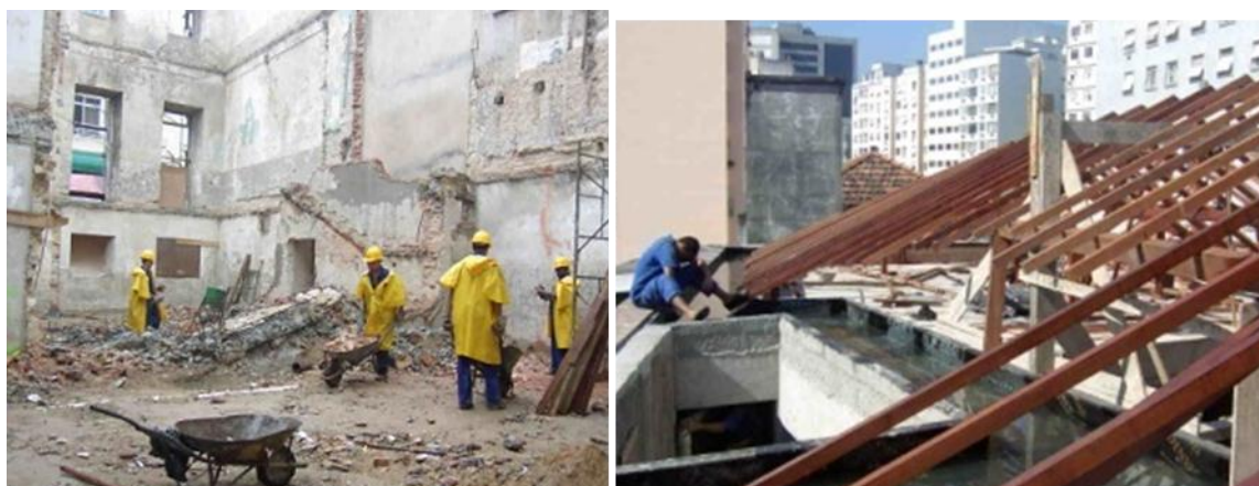
Figura 12 (a) e (b) – Fases da obra no casarão, 2004 a 2005.
