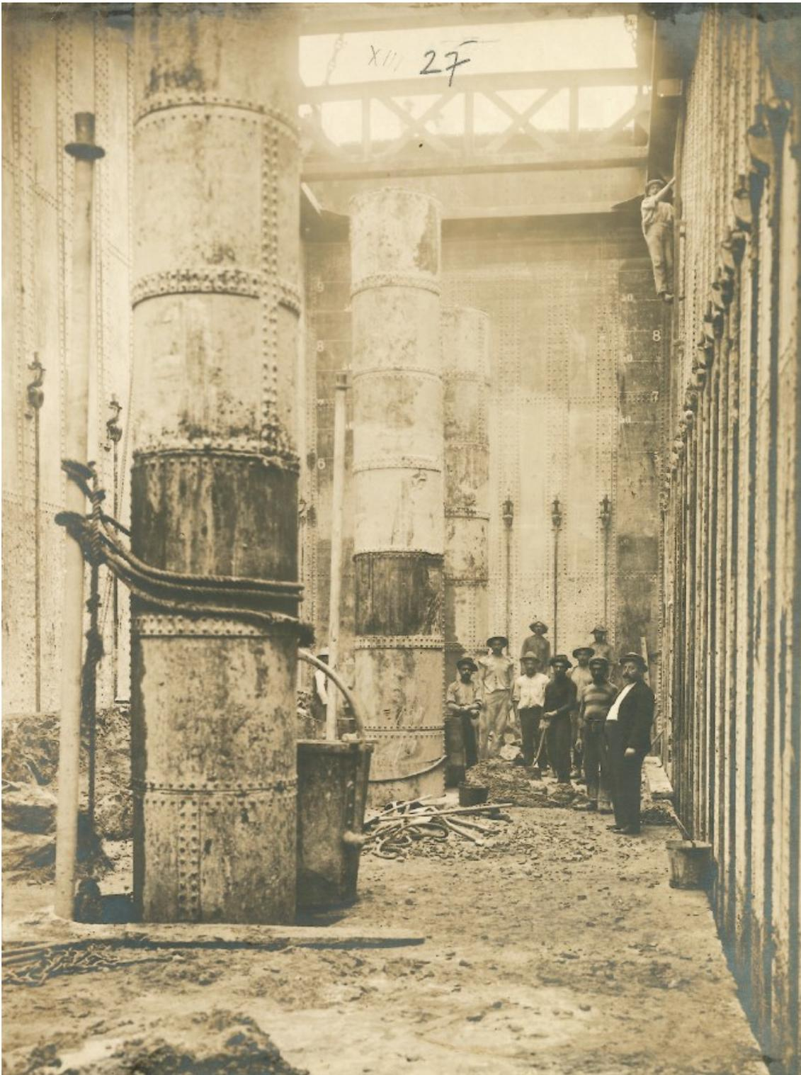
Figura 33 Elevação da muralha no interior da ensecadeira depois do enchimento da câmara e retirada das campânulas. (Acervo INPH)
