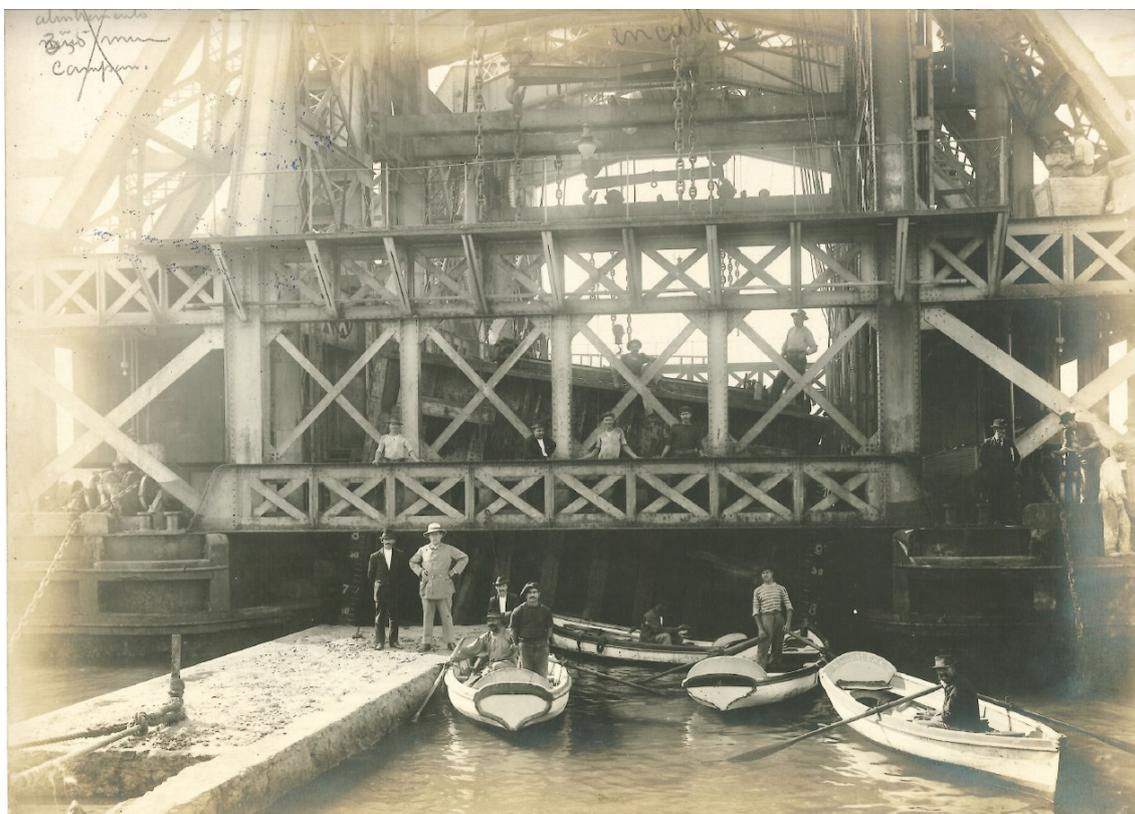
Figura 26 Foto da construção do muro do cais - trabalhadores em frente à ensecadeira. (Acervo INPH)
