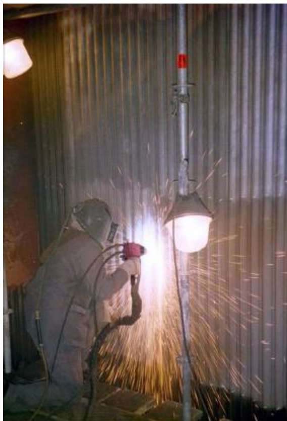
Figura 7: Processo de aspersão térmica manual por arco elétrico. Extraído de Rodjnem, 2016.
