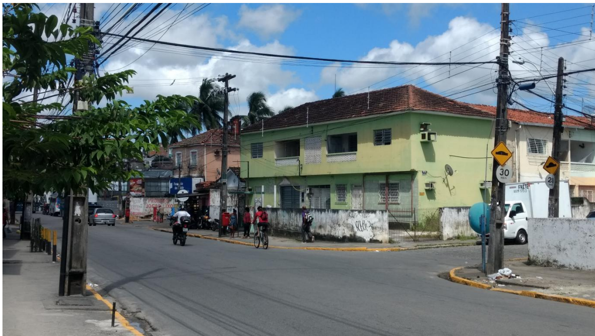
Imagem 1 - Entrada do Vasco da Gama
