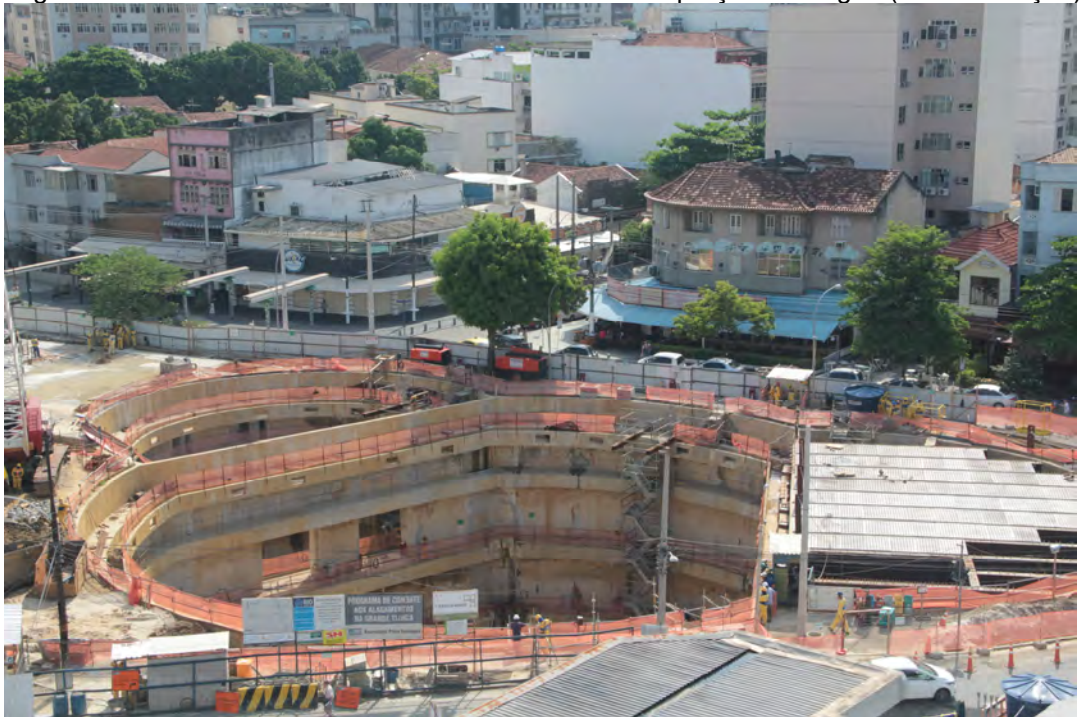
Figura 4 – Reservatório de amortecimento de cheias da praça Varnhagen (em construção)
