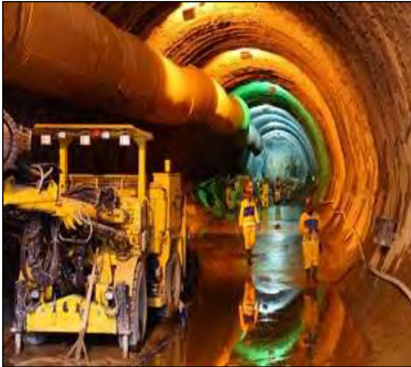
Figura 5 – Desvio do Rio Joana através de túnel
