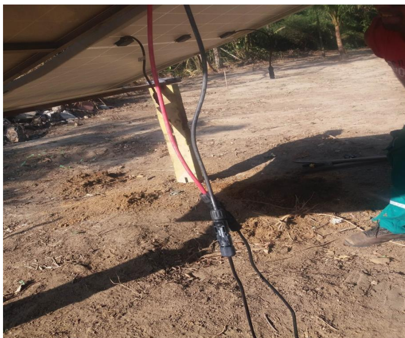
Figura 14 - Placas conectadas em paralelo
