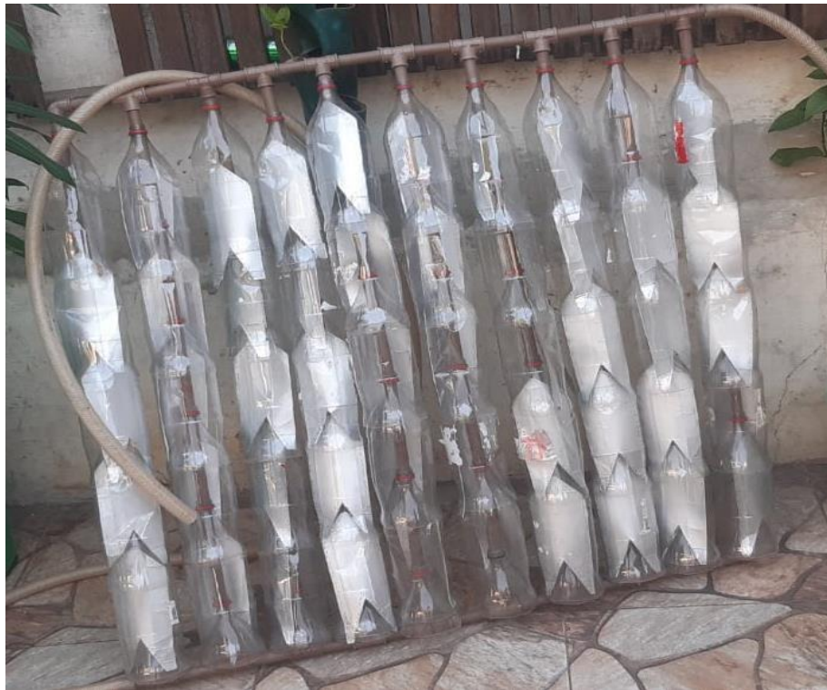
Figura 18 - Sistema de aquecimento de água por Boiler solar transladado para a Capela Sustentável
