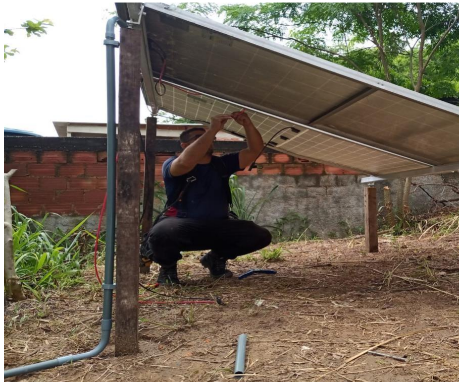
Figura 16 - Sistema de geração fotovoltaica em construção na Capela Nossa Senhora da Esperança: “Capela Sustentável”
