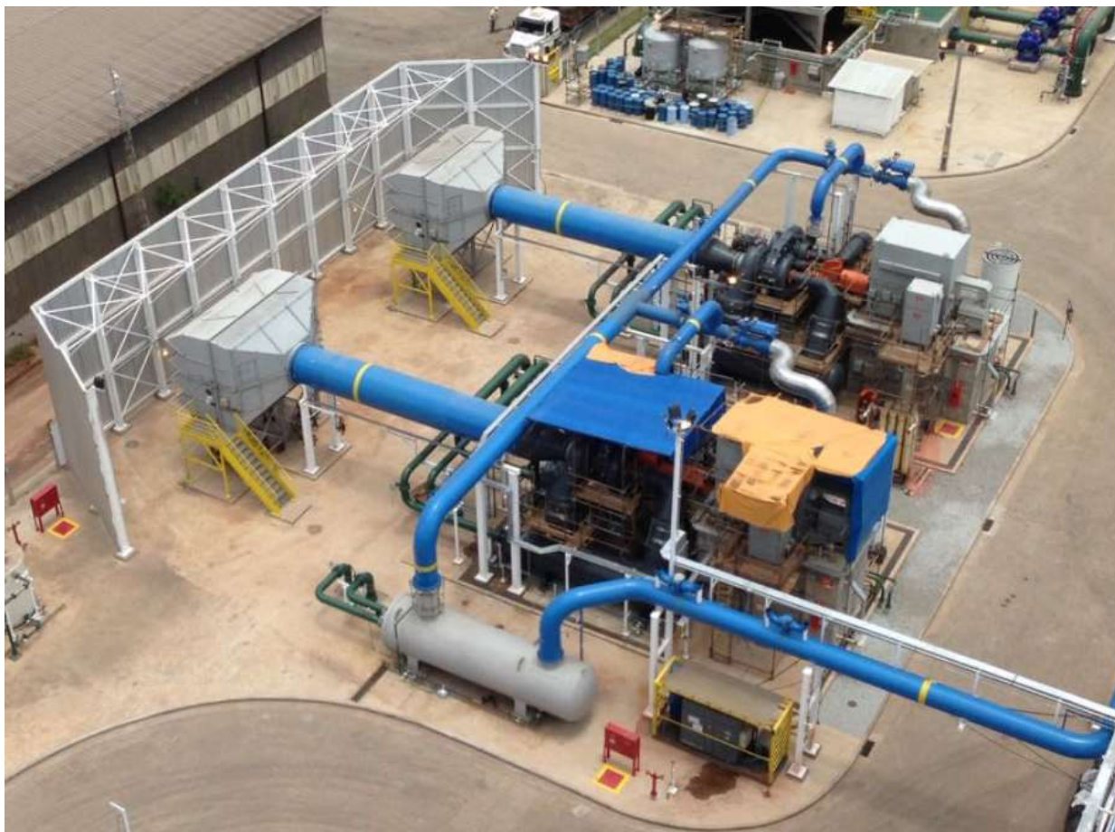
Figura 20 – Modelo estrutural: Fundação executada (vista superior) [3].
