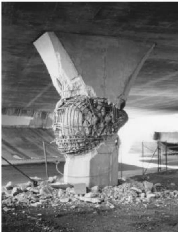
Figura 2 - Dano por ruptura de “coluna curta” após o sismo de Northridge ocorrido em 1994.
