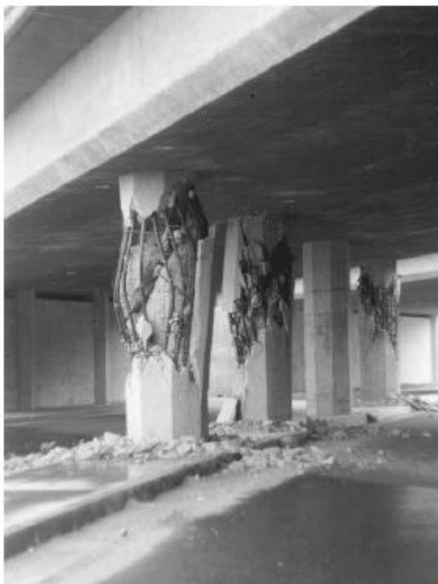
Figura 1 – Dano por reforço horizontal insuficiente após o sismo de Kobe ocorrido em 1995.
