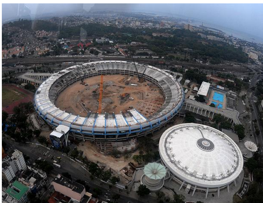
Foto 1 – Reforma do Maracanã
