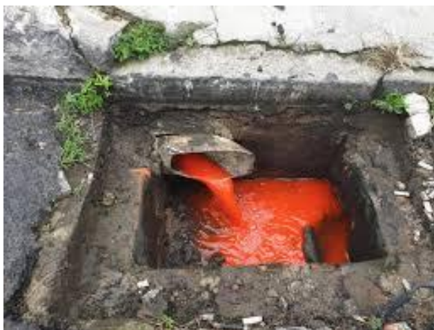
Figura 50 – Teste de Corante na Rede de Esgotamento
