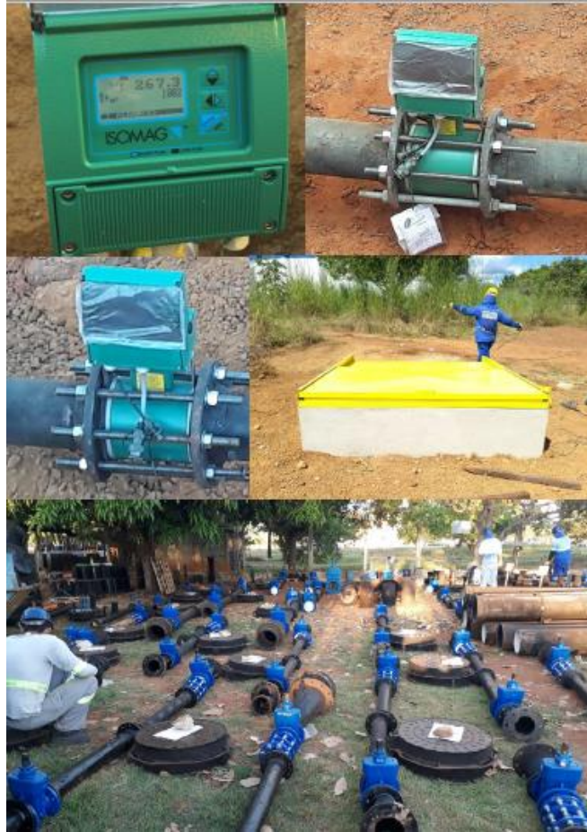
Figura 31 – Instalação de Macromedidores BRK Ambiental Tocantins
