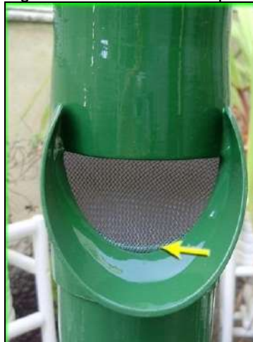
Figura 18 – Filtro auto-limpante com tela fina.
