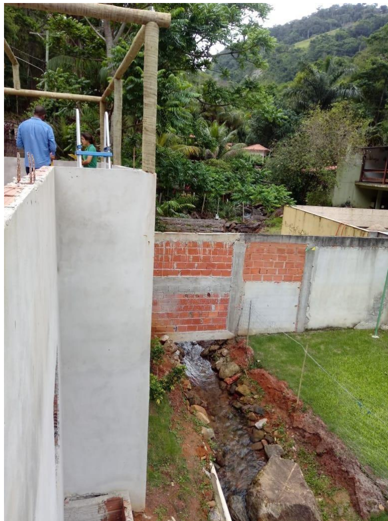
Figura 7 - Muro sobre riacho, apropriação de bem público.
