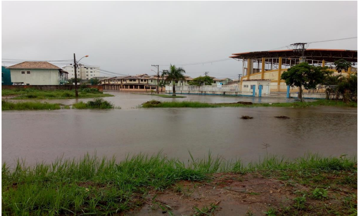
Figura 14 - Transbordamento do Rio Jundiá no Bairro Âncora: inundação de casas, do posto de saúde e do Ginásio Público, em 8/11/2018.
