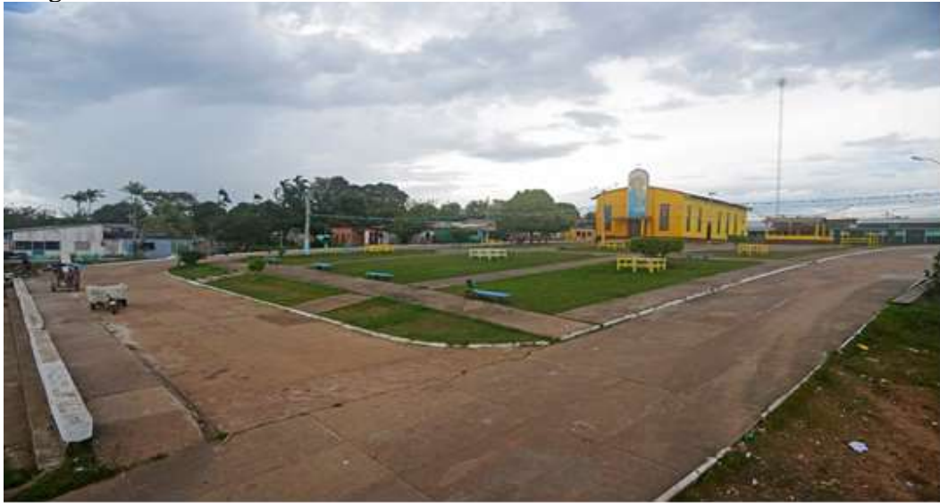
Imagem 8 - Vista da frente da comunidade
