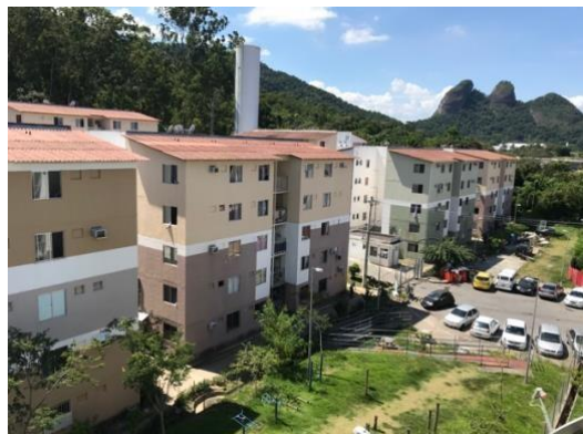
Figure 5 - Logements sociaux du Parque Carioca
