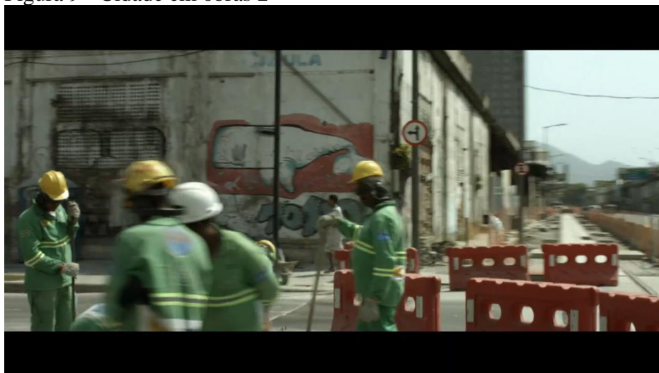
Figura 9 - Cidade em obras 2
