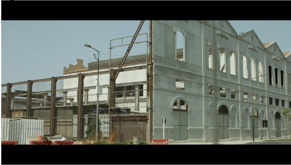
Figura 10 - Cidade em obras 3
