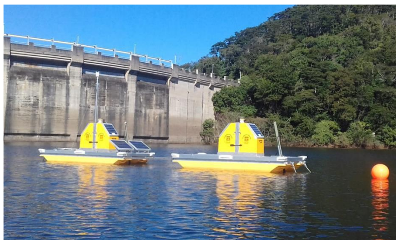
Figura 7 - Imagem do perfilador próximo à barragem.
