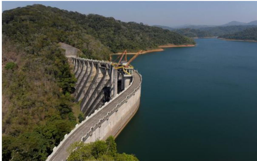
Figura 4 - Barragem do reservatório de Ribeirão das Lajes.
