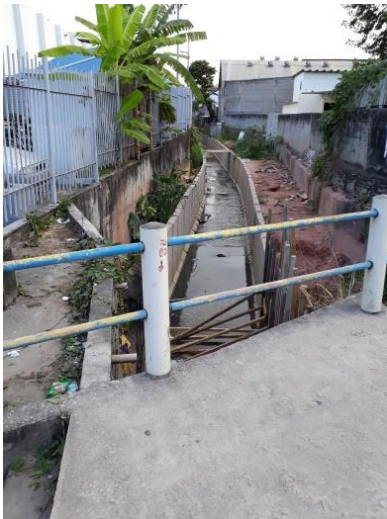
Figura 8 - Canalização do rio Pechincha
