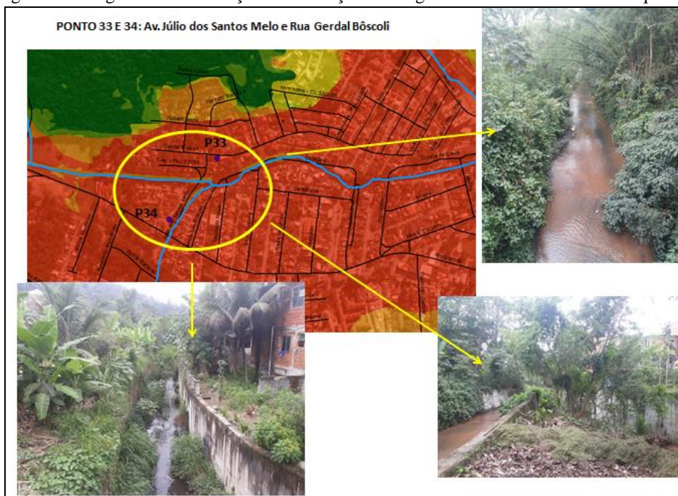
Figura 33 - Registros de inundação da Fundação Rio-Águas situados no bairro da Taquara.
