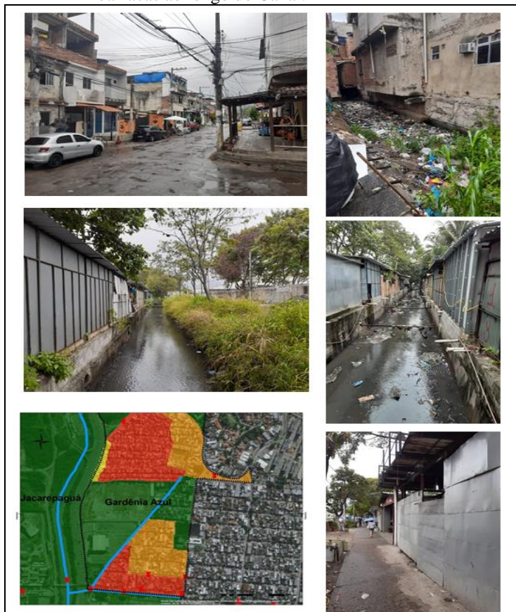
Figura 50 - moradias na Rua do Canal, bairro Gardênia Azul; despejo de lixo no Canal; ocupação das margens por barracas; lançamento de esgoto diretamente no Canal e barracas ao longo do Canal.
