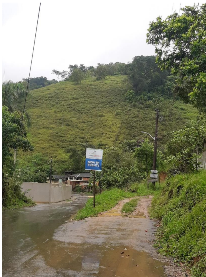
Foto 4 - Trecho de estrada asfaltado para um empreendimento Municipal
