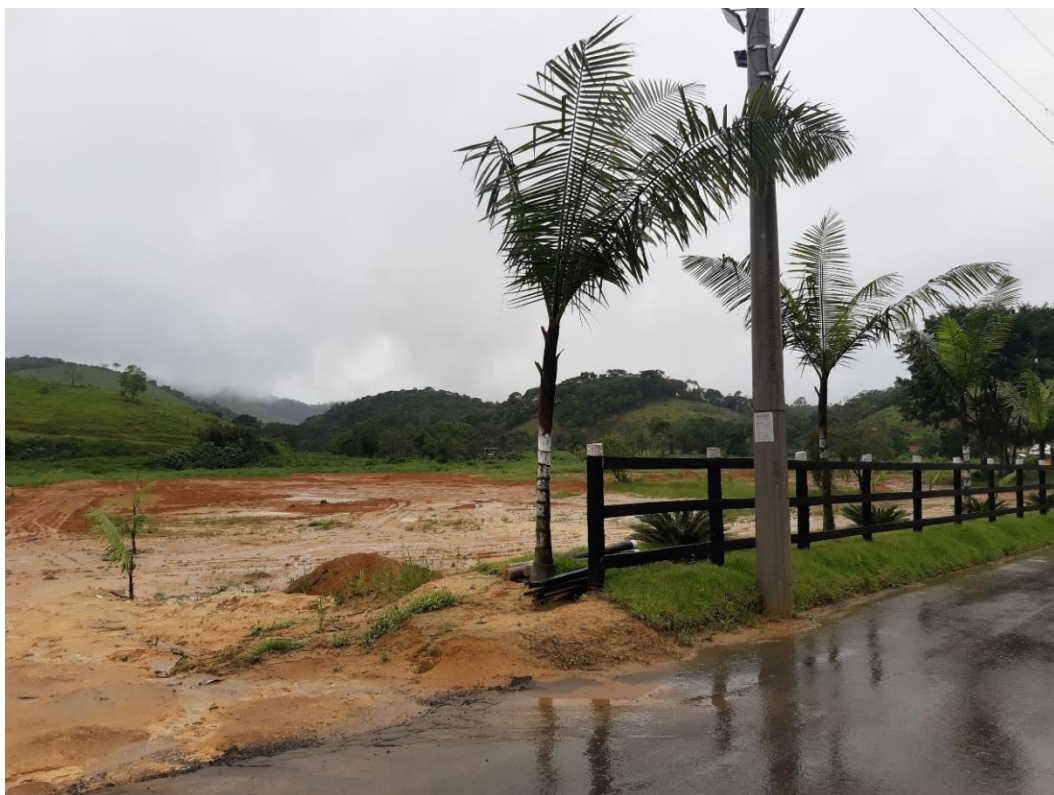
Foto 27 - Parcelamento de terras sem a placa de aprovação pela prefeitura
