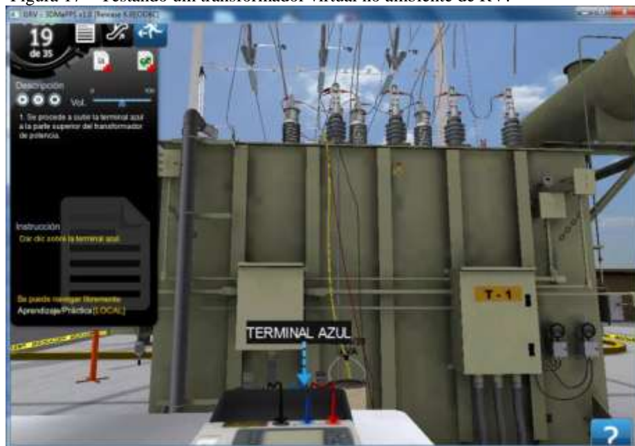
Figura 17 – Testando um transformador virtual no ambiente de RV.
