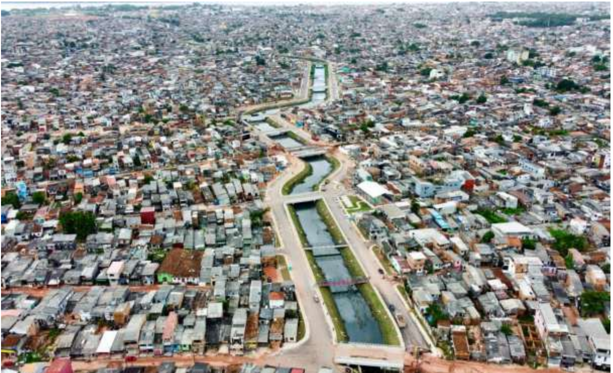
Figura 5 – Imagem aérea da macrodrenagem da bacia do Tucunduba.
