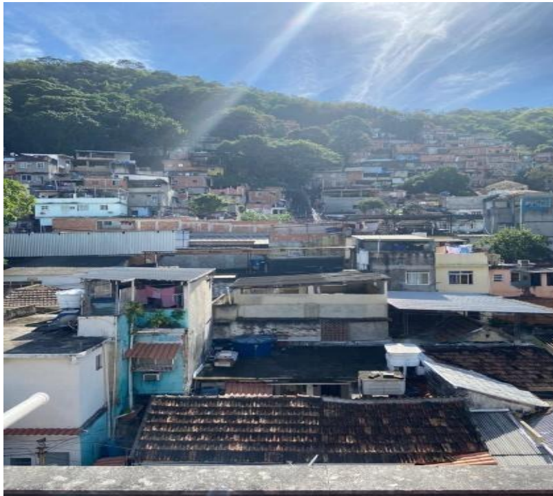
Imagem2: Lajes na Favela do São João/RJ
