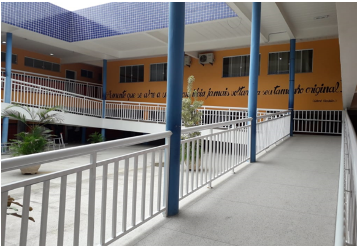
Imagem 3 - Rampa de acesso principal da escola
